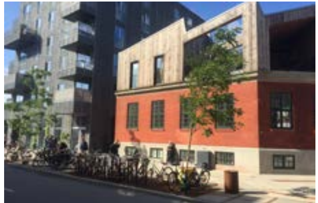
Roof terrace, Nordhavnen, Copenhagen.
